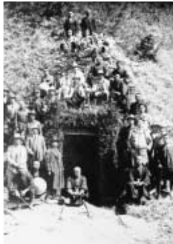
(写真1) 昭和24年5月中山隧道 貫通記念(小松倉抗口)
