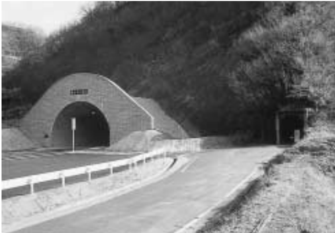
(写真3) 新中山トンネル(左)と中山隧道
