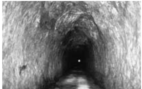
(写真2) 隧道内部
