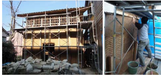
写真-2 土蔵修復作業の様子
